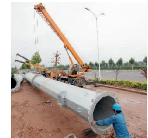
7月13日,县电业局施工人员正在组装110千伏龙源输变电工程线路铁塔。该工程位于县产业集聚区,计划于8月份投入运行。 王向阳 摄
