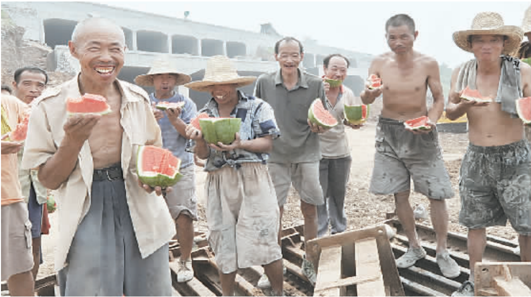
昨日上午，记者在市人民路延伸工程下穿焦晋高速公路立交桥顶进工程工地看到，施工人员正在利用休息时间吃西瓜。据施工方中铁十五局集团第二工程有限公司负责人介绍，当日是我市第七个农民工节，本来想让工人休息一下，可目前工期较紧，只好给工人买些水果，并给他们做些好吃的。
