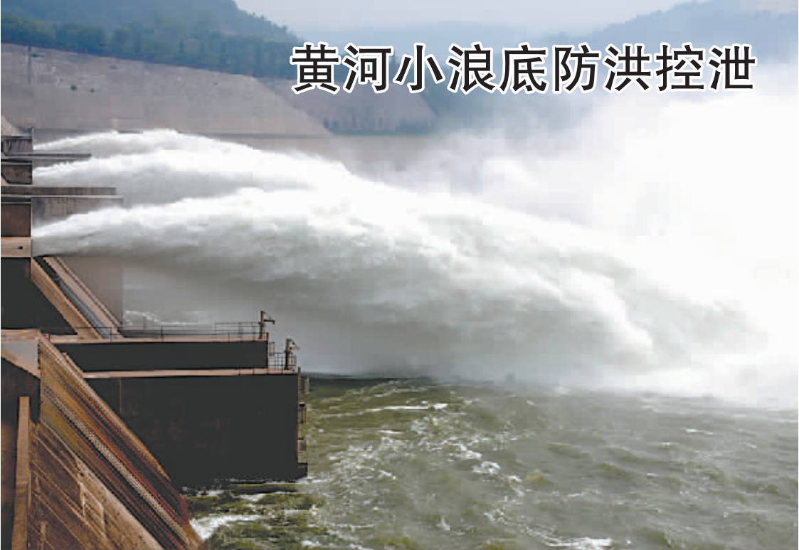
这是7月24日拍摄的黄河小浪底水库控泄的壮观景象。受三门峡水库泄洪影响,7月23日12时起,黄河小浪底、西霞院水库联合调度,出库流量按2600立方米/秒均匀下泄。据悉,此次洪水过程将历时7天左右。
