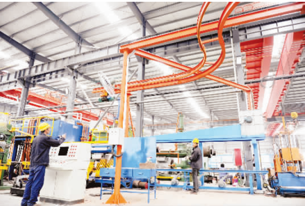
7 月 25 日，广东兴发铝业（河南）有限公司 10 万吨高档铝型材深加工项目工地，工人们正在调试设备。该项目总投资 10 亿元，主要从事高档铝型材精深加工，分两期建设，项目全部投产后年可实现产值 20 亿元，利税 2 亿元。 目前，该项目已进入全面的设备安装阶段。 李亚锋 摄
