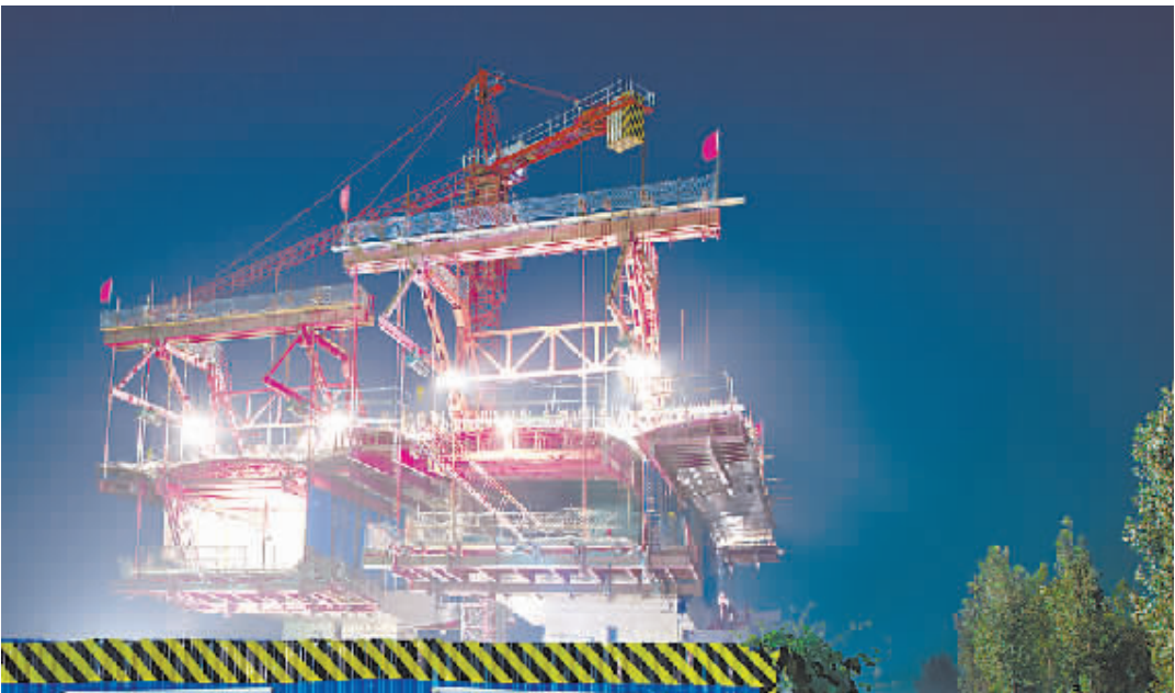
8 月 2 日，武西高速桃花峪黄河大桥施工人员正在夜间施工。在武西高速桃花峪黄河大桥建设中，武陟县委组织部和施工单位党组织联合，先后开展了主题为“黄河大桥党旗红，施工全线争先锋”的“共产党员先锋工程”创建活动，以“苦干 200 天，建功桃花峪，攻坚克难确保实现武西高速桃花峪黄河大桥基本贯通的工期目标”为主题的“六重六比”劳动立功竞赛活动，确保了工程安全高效建设。王志琪 马宁 摄
