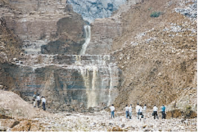
8月10日发生在浙江省舟山市岱山县涂镇沈家坑水库的垮坝事故目前已造成10人死亡、27人受伤。沈家坑水库集雨面积0.26平方公里,坝型为土坝,坝高28.5米,总库容23.8万立方米,属小(二)型水库,为非地方管理的水库。图为水库垮坝事故现场。(新华社发)
