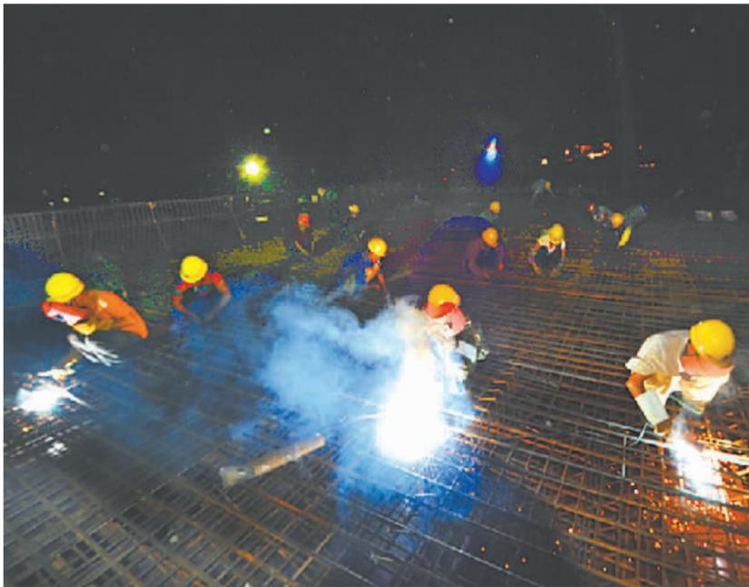
8月16日晚,记者在南北水调城区段丰收路桥施工现场看到,工人们正在电焊、绑扎钢筋等。该桥是总干渠与焦作市丰收路的渠路交叉建筑物,总长度620米,主桥长度75米、宽度57米。据悉,该工程9月31日前完成主桥施工、东西引桥及引道南半幅施工,具备半幅通车条件。 本报记者 李英俊 摄
