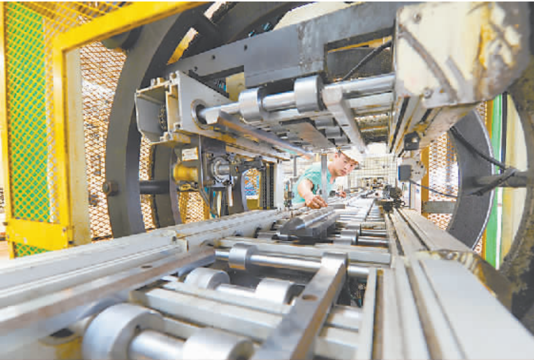
昨日上午,技术安装人员正在焦作瑞庆公司1号厂房安装调试设备。据悉,该公司自7月20日汽车发动机首批设备到位并开始安装以来,经过安装人员的精心努力,1号厂房设备已基本安装完毕,目前进入调试阶段,预计9月18日可进行试生产。
