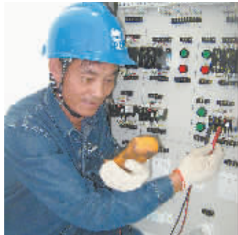
马四正在检修线路。 本报记者 张冬 摄
