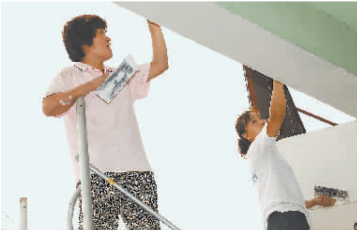
8月22日,县住建局组织人员在詹泗路三条龙段,对不符合标准的户外广告牌进行拆除(上图),并对墙体进行统一粉刷(左图)。龙源路、詹泗路城区段综合整治工作开展以来,全县各责任单位针对两路段中的违规建设、违法经营和环境卫生“脏乱差”等问题开展整治活动,着力营造整洁优美、文明有序的城市环境。 翟晓飞、李秋杰 摄
