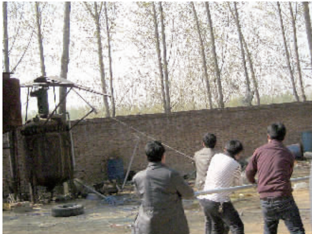
拆除非法生产设备
