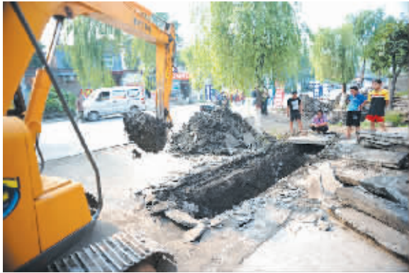
博爱县竹区水系的清淤现场。当地政府试图通过该工程恢复竹林的地表水灌溉。
