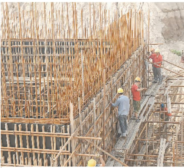
8月29日下午,建筑工人正在县第二污水处理厂进行消毒池墙体钢筋绑扎工作。该工程位于木棠新区,总投资约8899万元,建成后日处理污水能力达3万吨。翟晓飞 刘爱国 摄
