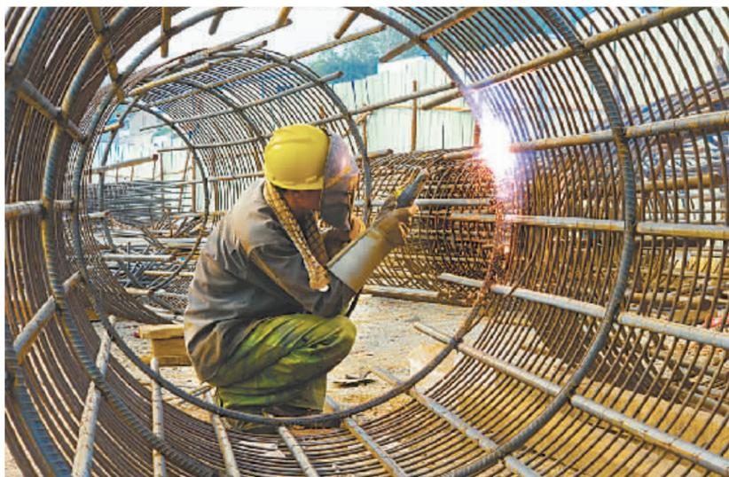
昨日上午,记者在南水北调二线跨渠桥施工现场看到,一名工人正在焊制桥墩所用钢笼。据悉,该桥跨越南水北调主干渠,全长820米,建成后可提高焦作市景观效果。截至目前,该工程主桥桥墩浇筑、预应力拉张及灌浆、防撞墙浇筑已全部完成,南北两个引桥及匝道正在紧张施工中。本报记者 李英俊 摄
