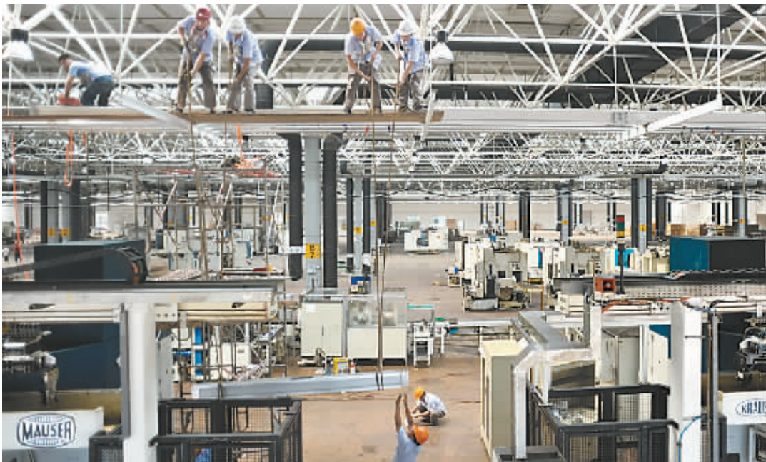
昨日上午，总投资25亿元的奇瑞汽车焦作发动机生产基地一号厂房内，员工们正在紧张地安装调试从德国进口的发动机缸体加工线。该生产线预计本月下旬安装调试完毕，国庆节前可生产出第一台发动机。 本报记者 田建明 摄
