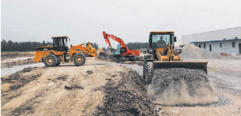
9月18日,市世纪东路项目承建方、河南省交通建设有限公司组织十余台大型机械,集中进行清淤换填和级配碎石铺筑作业...
