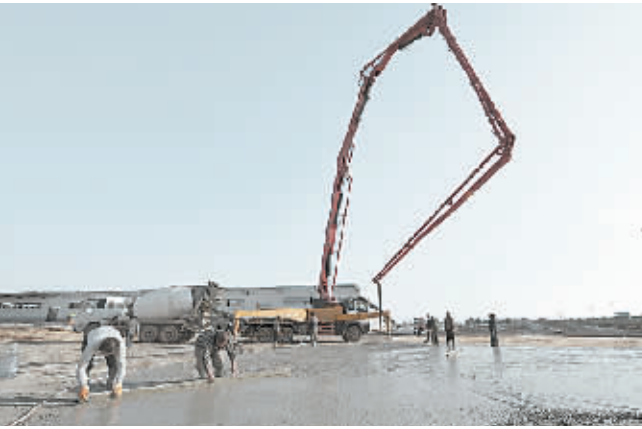
国庆长假期间，在位于孟州市西魏镇的河南德众公共保税中心建设工地，工人们正在紧张施工。河南德众公共保税中心总投资 15 亿元，整个工程建设分两期完成，其中一期工程占地 500 亩，将于今年 11 月底竣工并投入使用。 本报记者 杨 帆 摄
