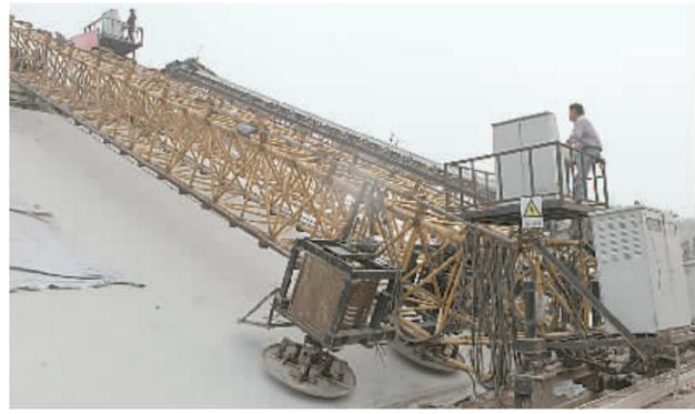
10月8日,在南水北调中线工程总干渠焦作2段第一施工标段,河南省水利第二工程局的建设者正操作大型衬砌机进行渠道衬砌作业。据悉,该局承担5.1公里渠道的施工任务,目前已完成今年年度目标的76%。 崔晶 摄
