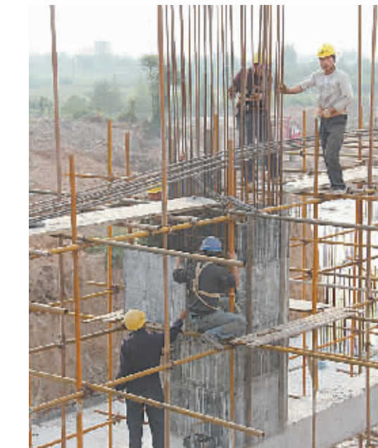
双节期间,西部工业集聚区内各个项目工地建设如火如荼。截至目前,西部工业集聚区已经竣工的投资1亿元以上的项目有12个,投产后预计年可实现销售收入31.55亿元、利税6.6亿元。图为建设者正在河南佰利联化学股份有限公司年产20万吨氯化法钛白粉项目处施工。 许来伟 摄
