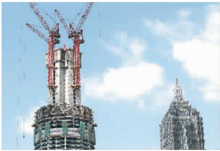
在建的上海中心大厦(左侧)。近日,在建的上海中心大厦主楼核心筒结构已施工至 81 层,高度已达 378 米。根据计划,年内上海中心大厦的建设高度将达 400 米。 (新华社发)
