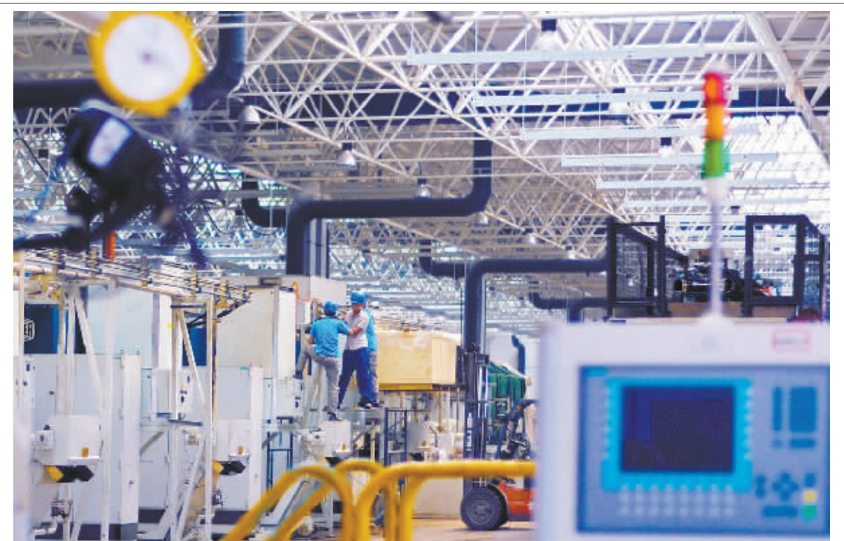
日前,总投资25亿元的焦作瑞庆汽车发动机技术有限公司年产61万套汽车发动机生产线项目1号厂房内,工人正在对从德国进口的发动机缸体加工线作最后调试。目前,该生产线已经安装完毕。 本报记者 田建明 摄
