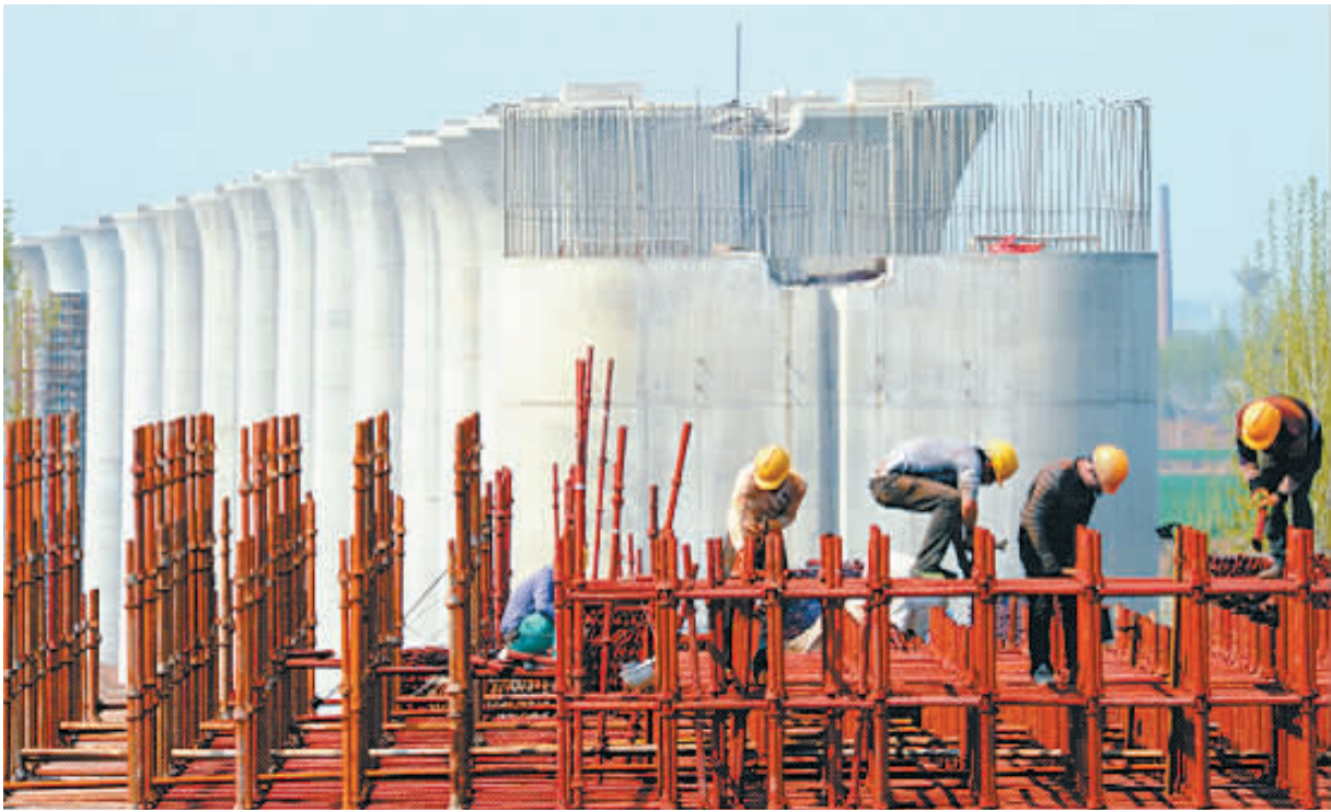
郑焦城际铁路云台大道立交施工现场。
