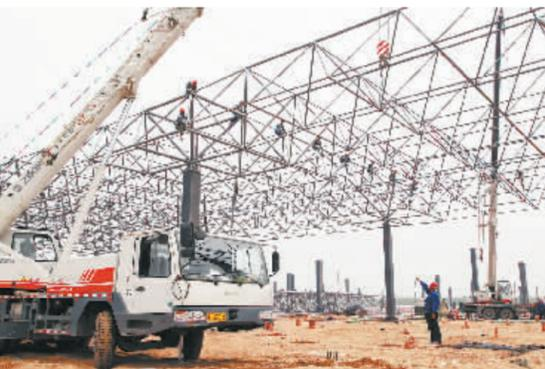
4月12日,瑞庆汽车发动机生产基地厂房建设吊装第一网架。刘昆摄
