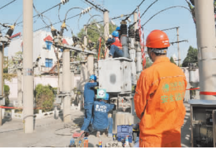
10月14日,市电业局变电检修部对全市变电设备进行全面检查,及时发现隐患并进行消除,确保辖区供用电安全。图为工作人员正在对35千伏崔庄变电站进行检修。李海洲 秦大江 摄
