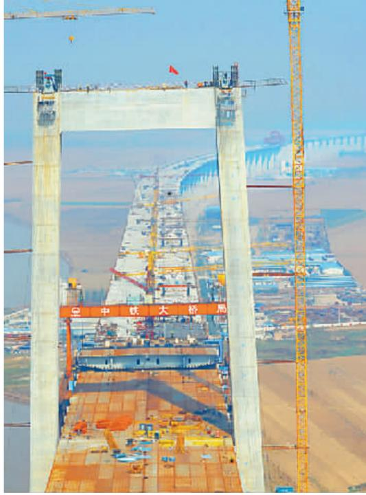
昨日上午，施工人员正在武高西桃桃花峪黄河大桥主桥上平架梁架，为大桥主桥合龙作最后准备。该主桥于2009年12月1日开始施工...
