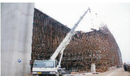
桃花峪黄河大桥桥面现浇施工。
