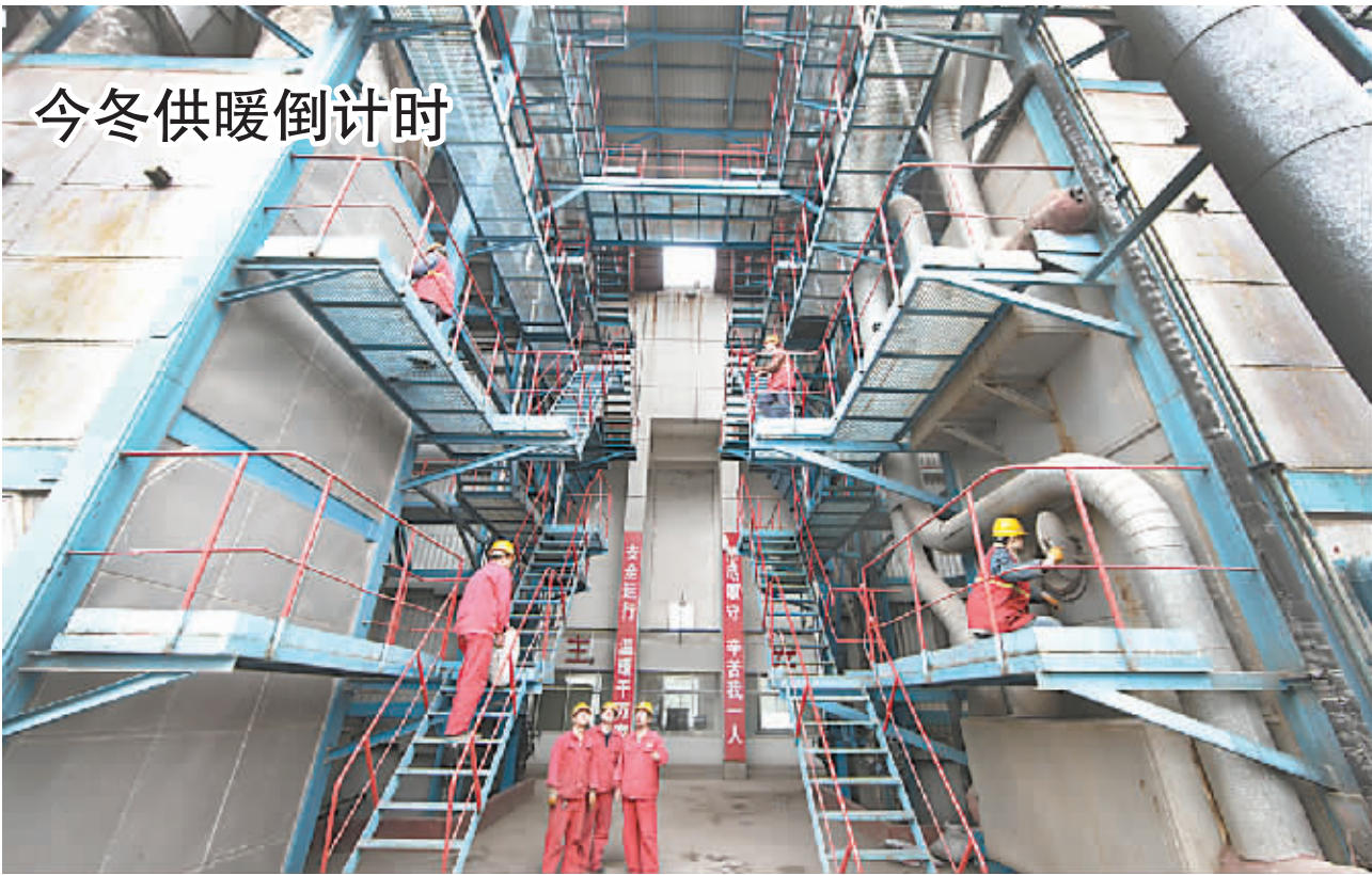
今冬供暖倒计时 昨日上午，市绿源热力有限公司员工正在对今冬供暖的两台锅炉进行运行前的最后一次检修维护。该公司多措并举，克服困难，目前已发展供暖面积 56 万平方米，2019 户居民的民生改造工程和 67 个庭院的管网加试水压工作也已完成，两台供暖锅炉开始暖炉，以确保 11 月 15 日正常供暖。 本报记者 赵耀东 摄
