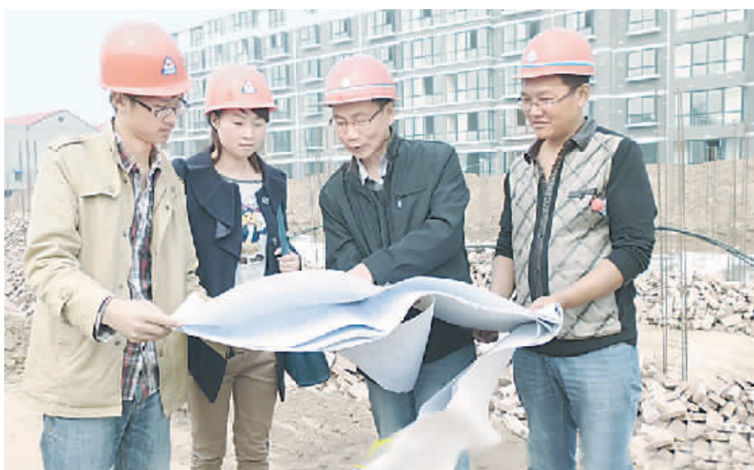
对于涉及民生的建设项目,修武县严格按照政府监管、社会监督、媒体监督三位一体的工程质量监督验收程序,确保质量过硬、程序规范、监督到位。图为10月29日,该县建委的质监人员在华公馆三期房产项目工地检测施工质量。牛晋粮 范秀丽 摄
