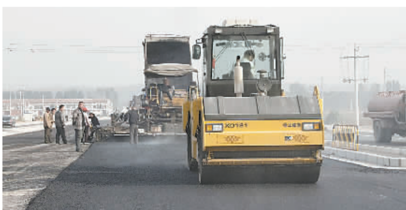
日前,孟州市高新区全长1200米、宽37米的建功路项目一期工程地基已处理完毕,路缘石、人行道已铺设完毕。因为工人正在铺设沥青面层。梁怡摄
