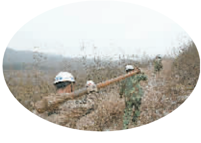
人工搬运塔材上山
