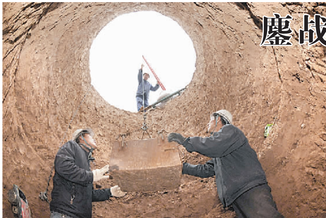
人工开挖铁塔基础
