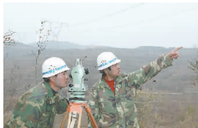
铁塔基础精准定位
