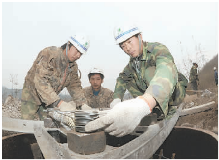
固定浇筑模板
