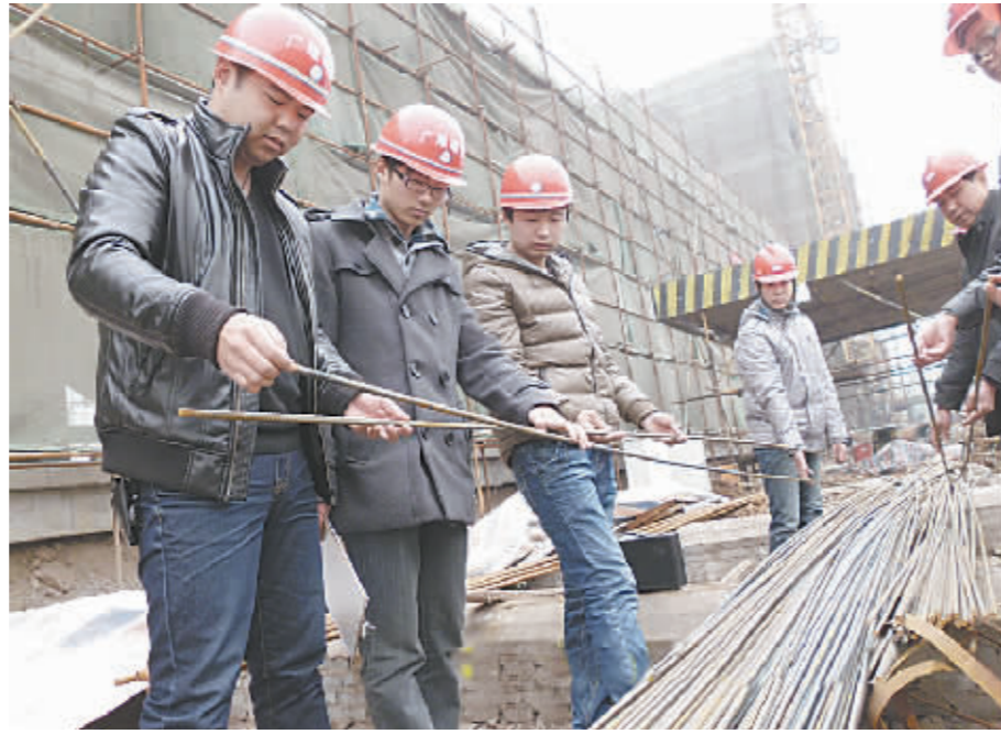
修武县住房和城乡建设局严把建筑材料准入关,定期派出质量监督检测人员深入辖区建筑工地,对钢材、水泥、砌块等进行复检,杜绝使用假冒伪劣建材现象,确保工程质量。图为11月19日,该局质检人员在修武县长途汽车客运站工地检查钢材质量。
