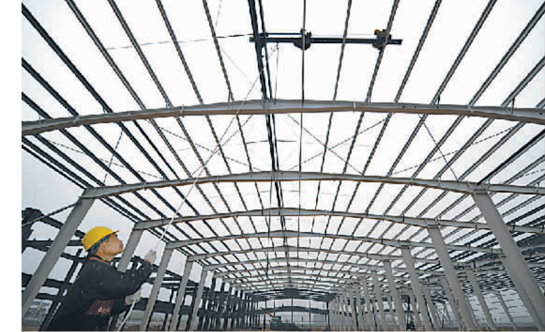
昨日,在修武县伊寨牛肉产业化项目施工现场,施工人员在精心施工。目前,河南伊寨牛肉股份有限公司投资16.5亿元在修武县建设的年屠宰10万头肉牛生产线等三个项目建设进展顺利,这三个项目建成达产后,可为当地提供3500个就业岗位,每年可增加销售收入52.5亿元,实现利税5亿元。 本报记者 杨帆 摄
