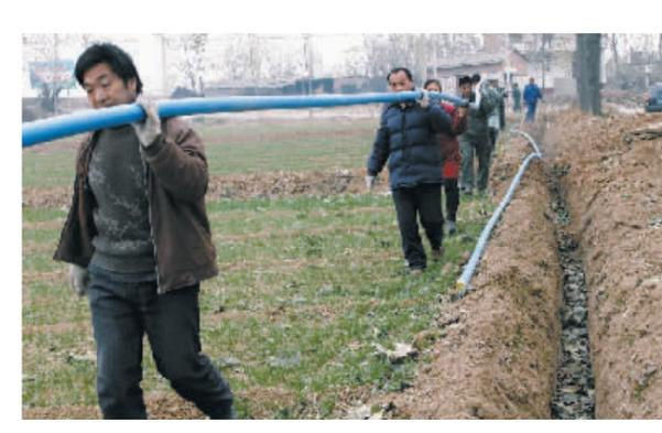
11月26日,孟州市赵和镇东赵村村民利用农闲时间在农田敷设埋管工程。今年年初以来,该市投入农田水利基本建设资金5500万元,新打、维修、配套机井361眼,敷设埋管286公里,维修渠道46公里,新增灌溉面积0.72万亩,新增节水灌溉面积4.8万亩。
