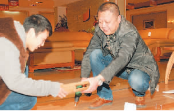
肖永红(右)正在铺地板。 本报记者 杨帆 摄
