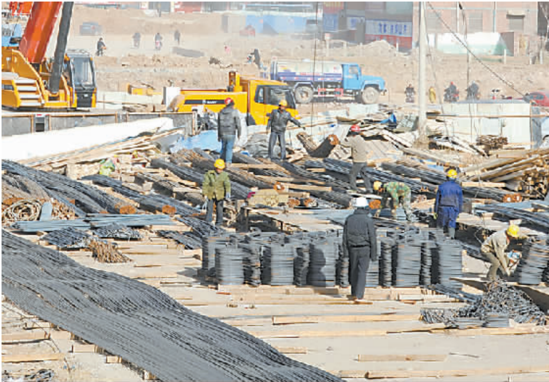
昨日上午，南水北调焦作城区段民主路桥科区一片繁忙景象。截至目前，该桥主体工程已完工，引道建设也已完成工程量的70%，预计明年年初该工程可全部完工。 本报记者 李英俊 摄
