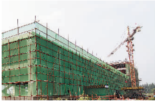
正在加紧施工的修武县汽车客运总站。
