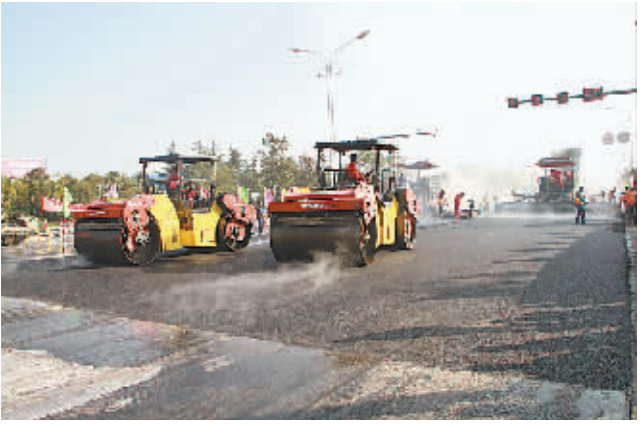
冢(滑县冢头营)沁(沁阳)线焦作至沁阳段一级公路改建工程施工现场。
