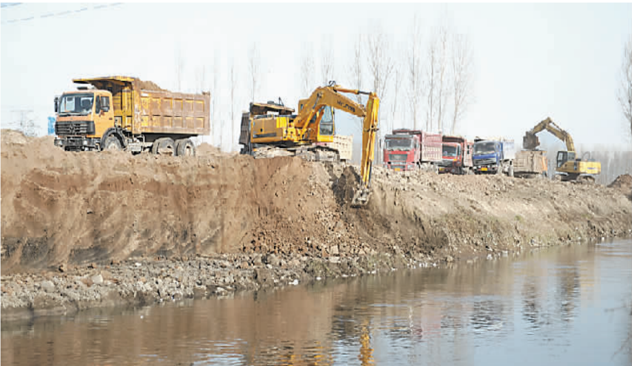
连日来，修武县每天出动大型机械五十余台对境内的大沙河河道进行拓宽疏浚。据介绍，在今冬农田水利建设中，该县加大河流治理力度，清淤疏浚河道，加固薄弱堤防，完善配套设施，而大沙河拓宽疏浚是其中重点工程之一，完成后将进一步提高河流防洪除涝标准，增强河流安全度汛能力。
