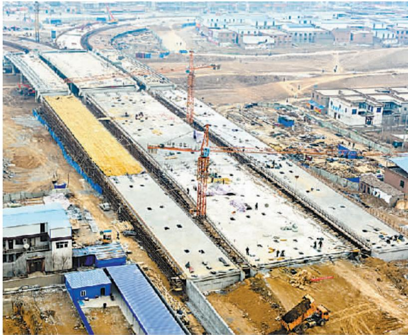
昨日上午,南北水调焦作城区段民主路桥已具雏形。该工程总投资6739万元,总长1108.675米,自2010年9月开工建设以来进展顺利,预计下月底桥宽中幅23.5米、边幅各12米,总工程量钢筋2648吨,混凝土25000立方米、沥青2150立方米。本报记者 田建明 摄
