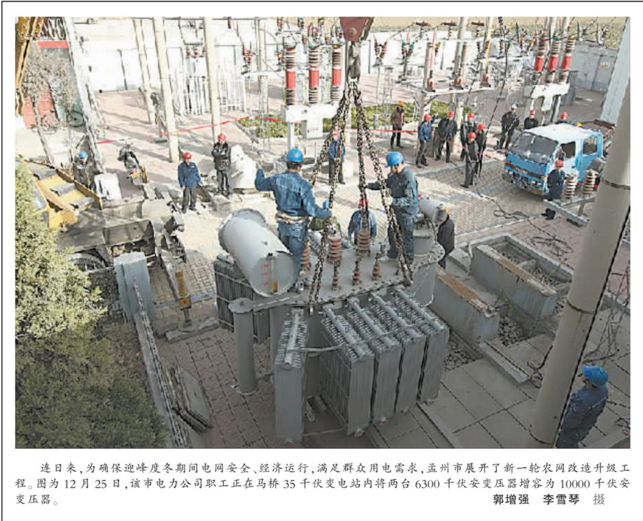
连日来,为确保迎峰度冬期间电网安全、经济运行,满足群众用电需求,孟州市展开了新一轮农网改造升级工程。图为12月25日,该市电力公司职工正在马桥35千伏变电站内将两台6300千伏安变压器扩容为10000千伏安变压器。郭增强 李雪琴 摄
