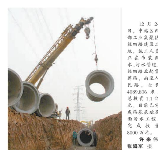
12月24日,中站区西部工业集聚区经四路建设工程,施工人员在吊装雨水、污水管道。经四路北起雪莲路,南至人民路,全长4089.806米,总投资1.1亿元,目前已完成路基基础及雨污水工程,完成投资8000万元。许来伟 张海军 摄
