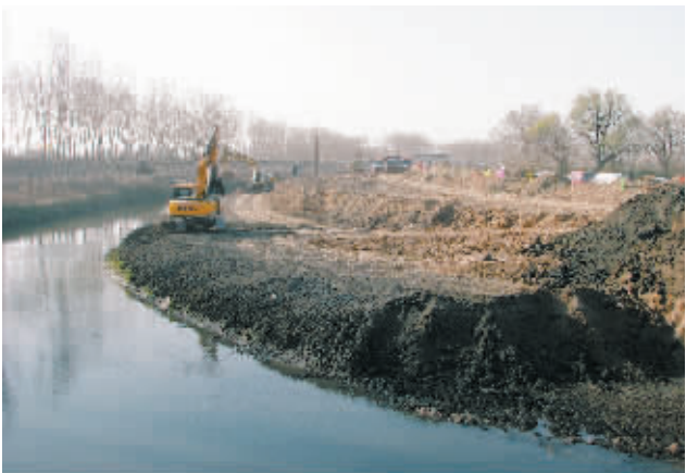
2012年修武县大沙河马道河段治理工程。 韩国平 摄
