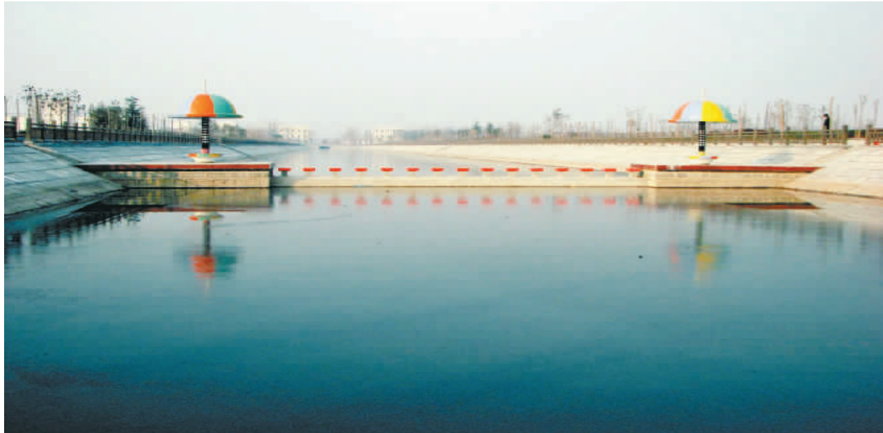
2007年修武县运粮河下段治理工程。
