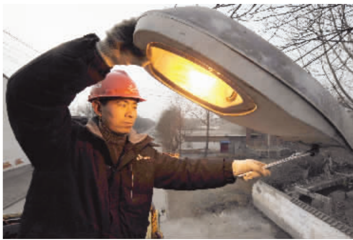
日前,市电业局路灯管理所对城区街道路灯进行了全面检修,确保各类设施安全、正常工作。截至目前,已累计维修路灯310盏,各类景观灯160盏。图为工作人员正在维修路灯。 范晶晶 李海洲 摄
