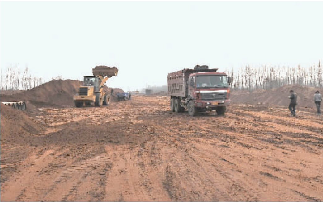
近日,木栗新区中轴大道正在紧张施工。为确保“两横一纵”道路在元旦前完成管网铺设,木栗新区管委会一方面,督促三条道路施工队列出施工计划,倒排工期,在保证工程规范、安全施工的前提下加快工程进度;另一方面,协调督促有关乡镇和县直单位加快推进坟墓搬迁、垃圾清运和电力、通信设备迁移等工作,确保道路顺利施工。
