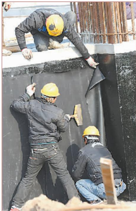
↑施工工人正在太极游泳馆做防水系统。
