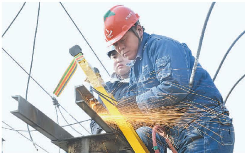
日前,沁阳市电业局20余名员工顶着严寒,奋战在35KV常平变电站增容改造施工现场。据了解,35KV常平变电站地处山区,投运时间过长,部分刀闸老化发热,供电可靠性不高。为确保山区人民正常用电,该局决定对其设备进行改造。据了解,这次改造将对7组35KV刀闸进行大修、1台5000KVA主变进行调试,更换全站综合自动化保护装置8套,改造变压器进线开关2台。
