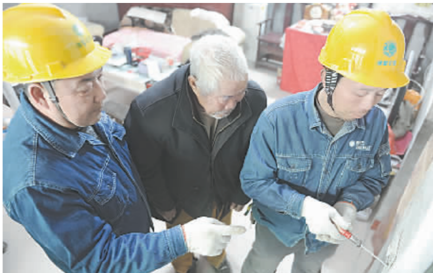
“谢谢你们帮我维修了家里的线路,这下我可以放心用电了。”1月12日下午,家住博爱县柏山镇的留守老人陈允富非常开心,该县两名供电员工义务上门为老人家里的用电设备进行了维修。入冬以来,针对农村留守老人和儿童多且安全用电知识普及相对欠缺的现状,该县电业局成立了9个供电服务小分队,走进“留守家庭”,为其电器设备进行全方位检查,新装漏电保护开关、更换绝缘老化的线路、现场指导留守老人和儿童注意用电安全事项。 程刚 毕利军 摄
