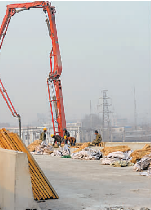
昨日下午，记者在南水北调焦作城区段山阳路施工现场看到，工人们正在进行扫尾工作。据该项目负责人介绍，经过施工人员的精心努力，该桥主桥路面已基本浇筑结束，只要天气允许，将全力以赴加快施工，争取早日完工通车。 本报记者 李英俊 摄
