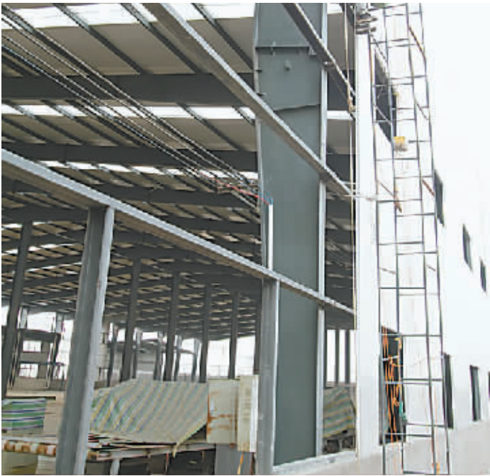
1月17日，位于温县武德镇的华荣包装材料有限公司二期工程正在紧张施工，预计2月份将全部建成投产。
