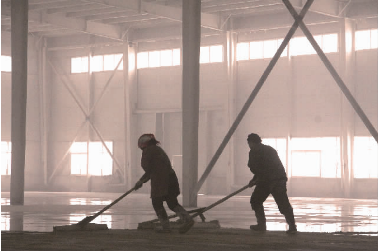
1月22日，工人正在辅仁集团医药产业园项目车间清洗地面，为设备安装做好准备。 该项目位于县产业集聚区，总投资10亿元，目前，冻干粉制剂、水针、口服固体制剂等6个生产车间已经建成，设备即将安装。项目全部建成投产后年产值可达到10亿元。本报记者 谭洁 摄
