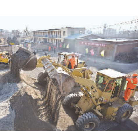
1月25日上午,在市公路局养护工区待王道班,19名一线养路工开展了冬季练兵活动。图为养路工在练习挖土机操作技能。
