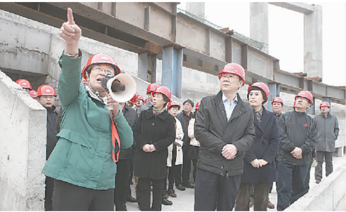
昨日下午，市委书记路国贤在新体育中心建设施工现场检查工作。市委常委、副市长迟军陪同调研。本报记者 赵耀东 摄
