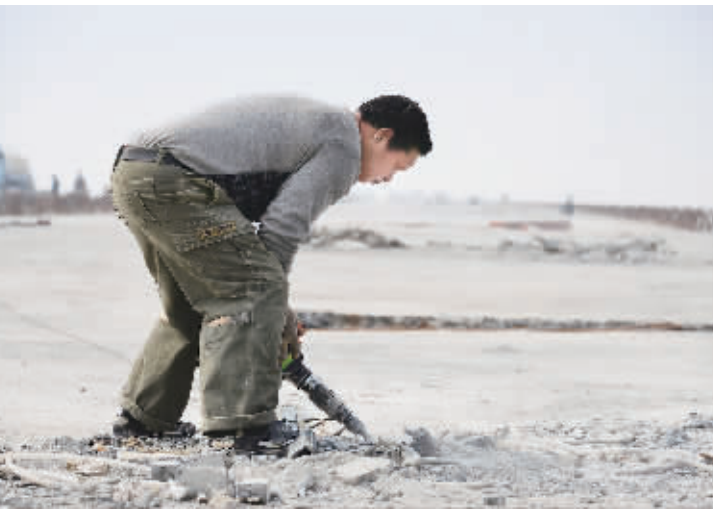
3月31日,中铁大桥局的建设者在桃花峪黄河大桥施工。桃花峪黄河大桥是武陟至西峡高速公路跨越黄河的“咽喉”工程,全长7691.5米。目前,大桥主桥已经贯通,主缆已安装完成,副桥正在进行桥面施工,预计年底建成通车。 王志琪 摄
